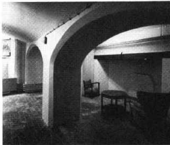
Afb. 14 Kelder met herstelde hardpartij
