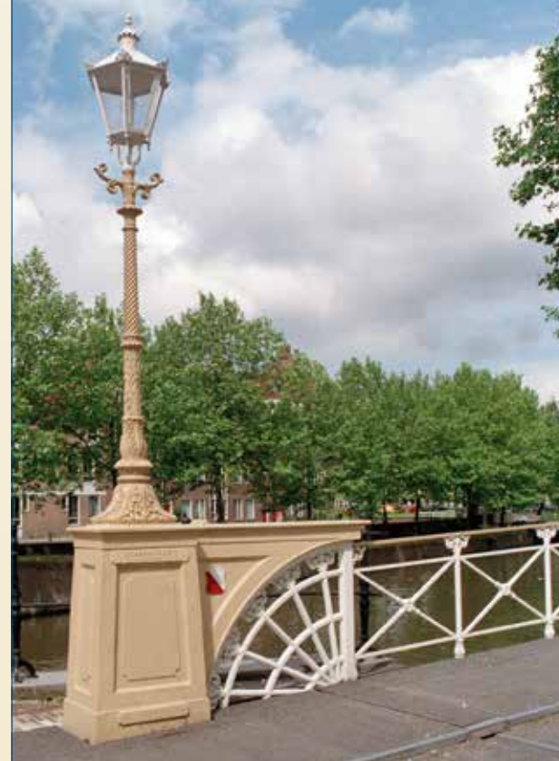
Bruggenhoofd van de gerestaureerde Weerdbrug in 1995. De voet van de lantaarn vermeldt 'Utrechtsche IJzergieterij 1862' en 'Gieterij Hardinxveld 1994'.
