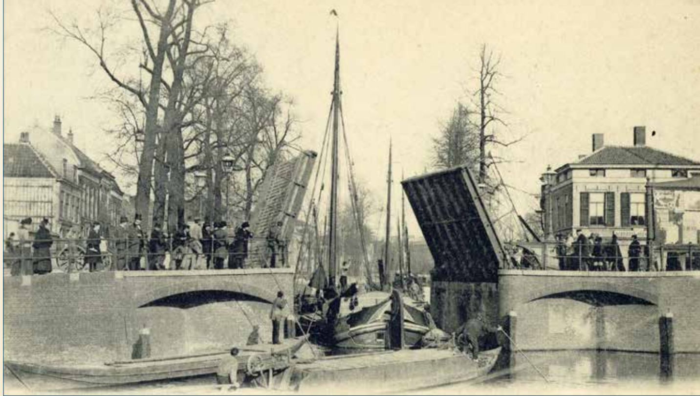
De door de Utrechtsche IJzergieterij vervaardigde basculebrug over de Stadsbuitengracht rond 1900. De gieterij lag slechts enkele honderden meters verderop.
