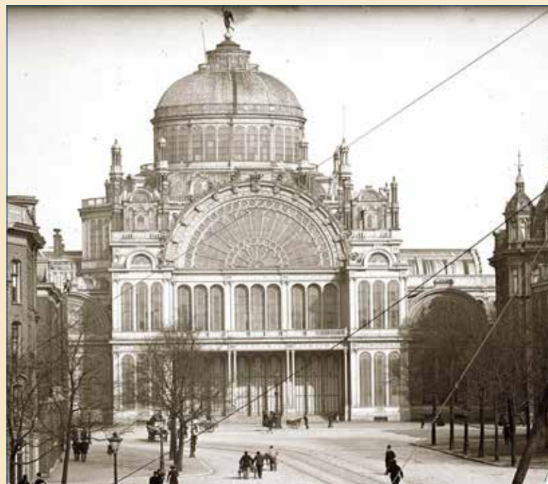
Deel van het Paleis voor Volksvlijt in Amsterdam met de door de Utrechtsche IJzergieterij vervaardigde koepel.
